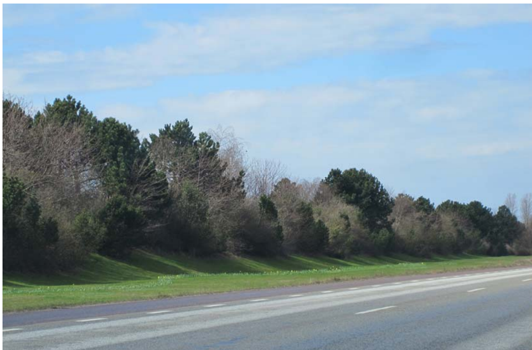
Östra infarten, bullerskydd på södra sidan.
