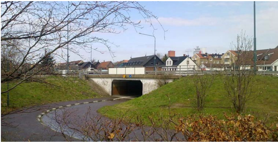
Gång- och cykeltunnel under Östra Infarten vid Östra Förstadsgatan.
