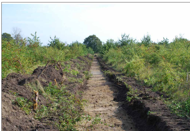
Schaktstråk gällande ytor för Terminalen 1 (Kommande incheckningsytor)
