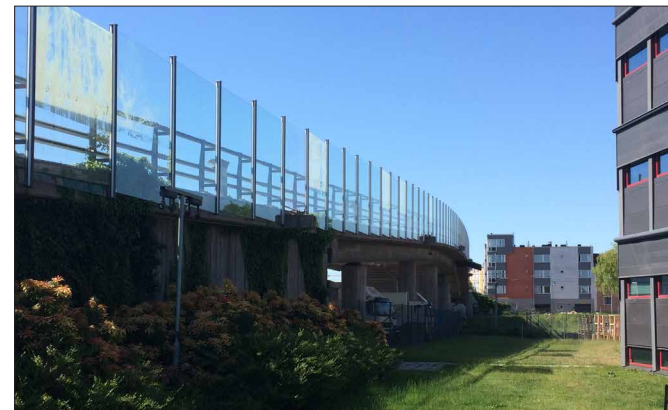
Bullerskydd i glas på brokonstruktion
