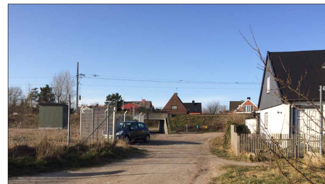
Befintlig gångport under Kontinentalbanan
